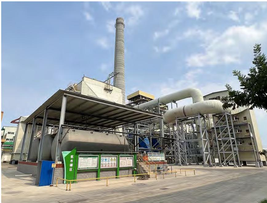
图 4-3 焚烧烟气处理设施现场照片
