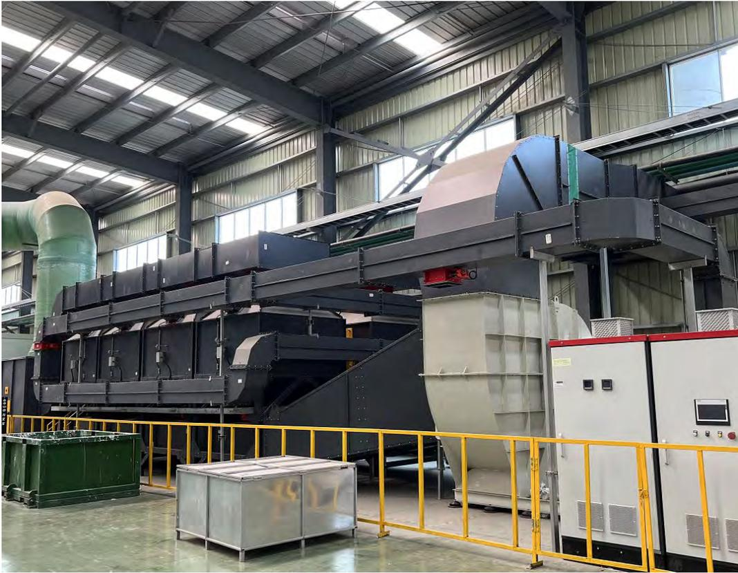
图 4-6 镀膜废气处理设施现场照片
