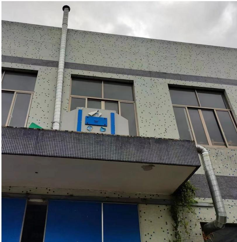
图 3-2 注塑废气处理设施现场照片
