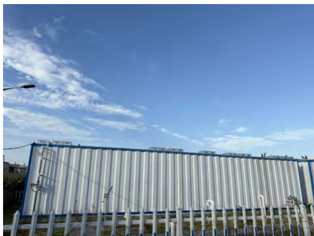
密闭污水处理设施
