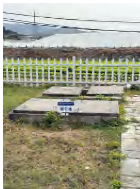
埋地密闭调节池
