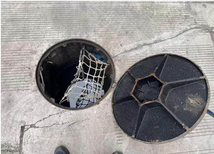
图 3-2 生活废水排放口现场照片
